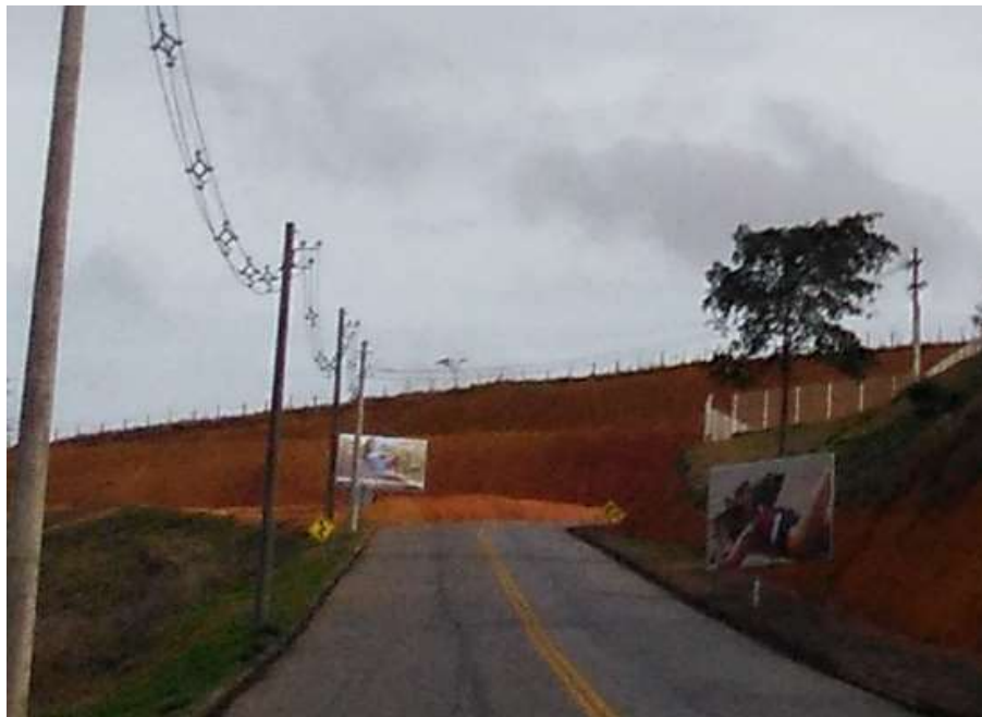
Fig.4: Local da Obra – Vista subida da rua de acesso ao Shopping.
