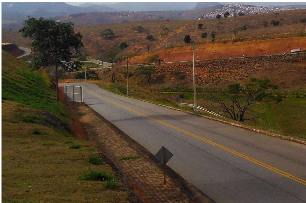
Fig.5: Local da Obra – Vista subida da rua de acesso ao Shopping.
