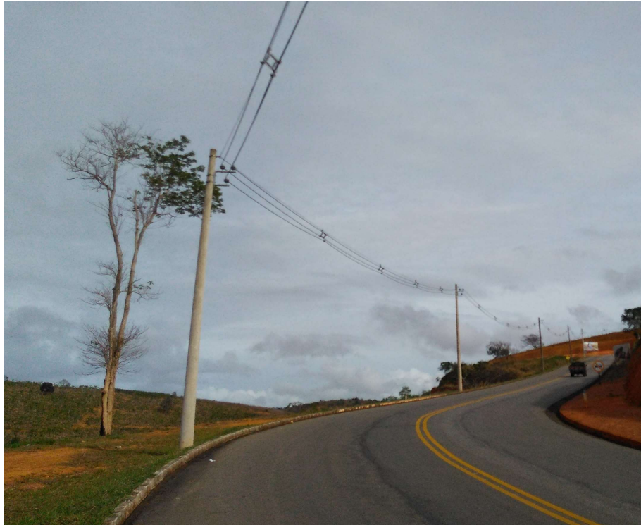
Fig.3: Local da Obra – Vista subida da rua de acesso ao Shopping.
