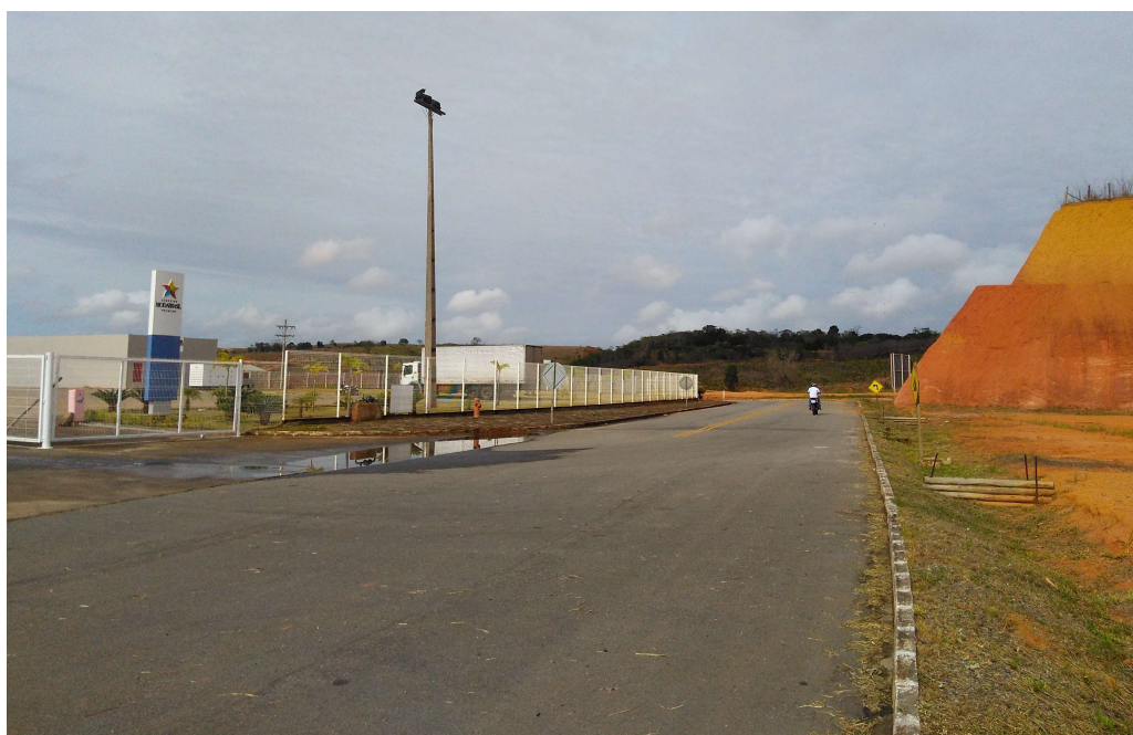
Fig.6: Local da Obra – Vista rua de acesso ao Shopping – Sem rede de MT.
