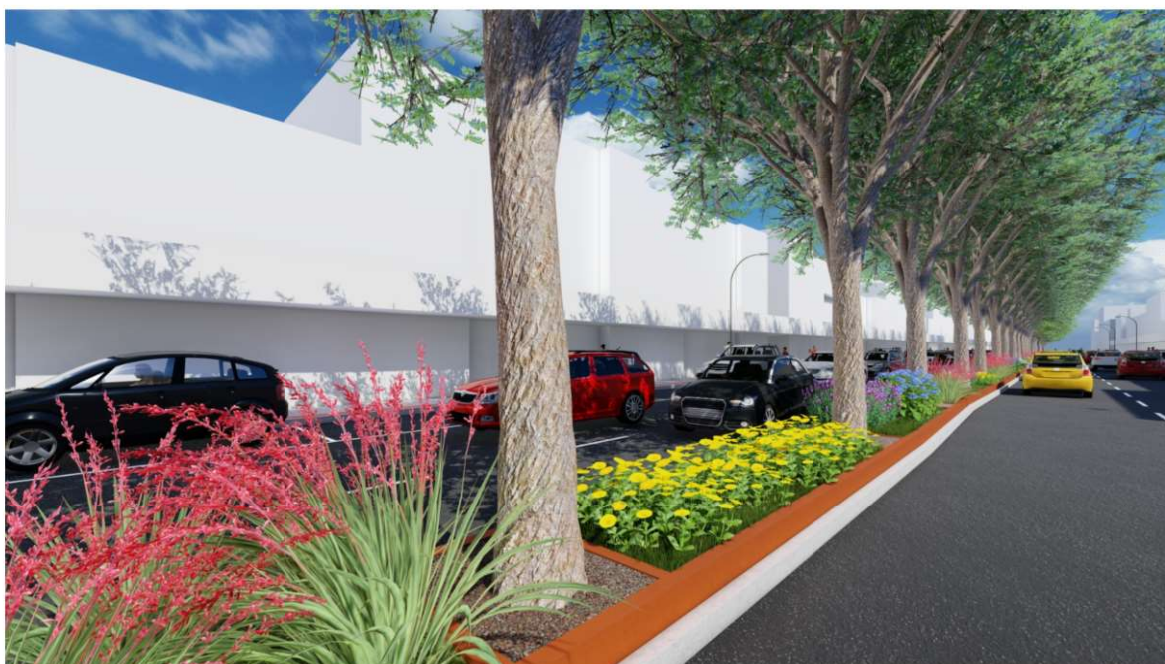
Figura 20 – aspecto geral de um trecho contínuo do novo canteiro, observando-se em primeiro plano, o meio-fio de proteção em torno dos troncos das árvores (fonte: Serpenge)
