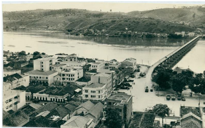
Figura 1 - Ponte Florentino Avidos inaugurada em 1928
