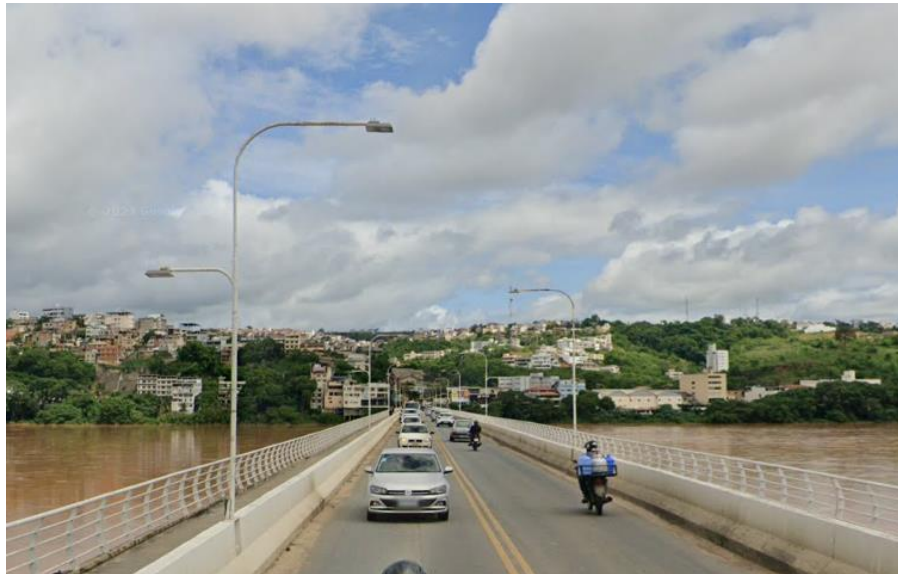
Figura 8 – Postes de iluminação.
