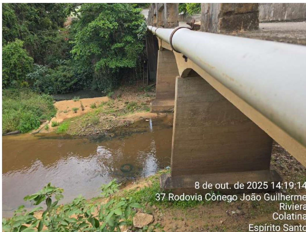
Foto 04: Pilares da ponte
