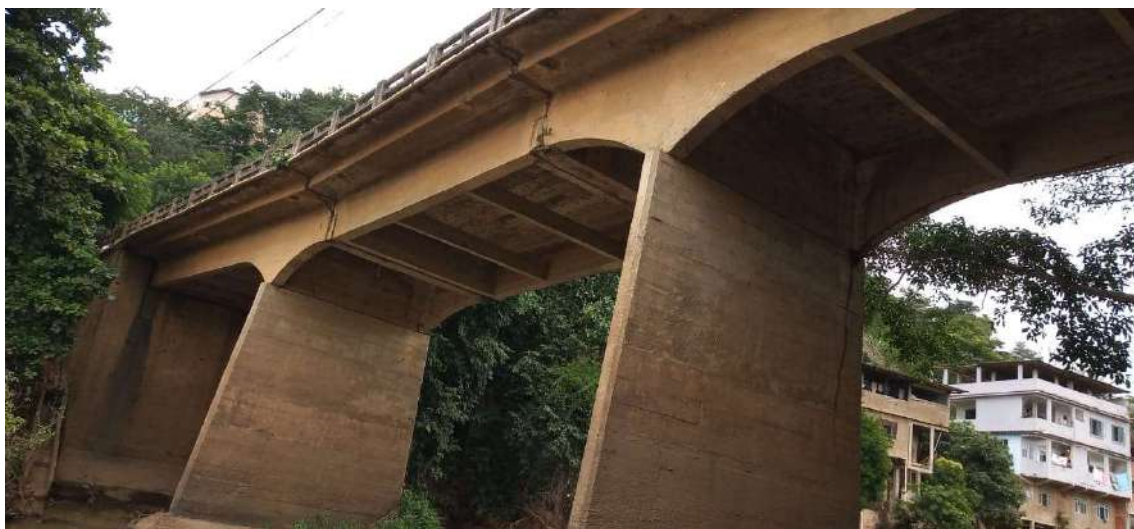
Figura 1 - Imagem da estrutura da ponte
