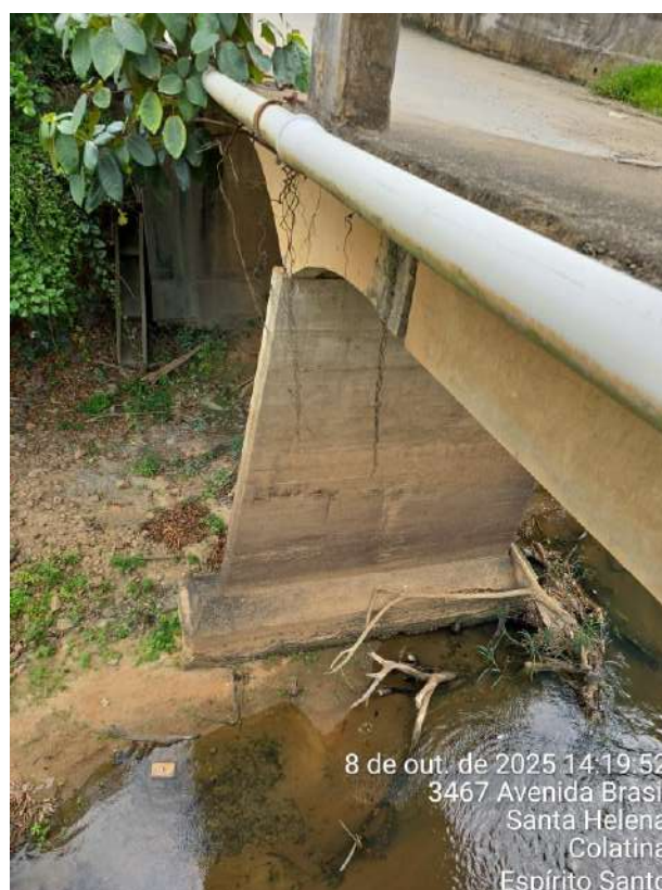
Foto 05: Pilares da ponte
