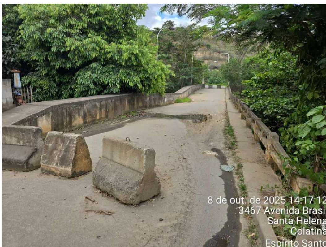
Foto 01: Vista da ponte lado do bairro Santa Helena
